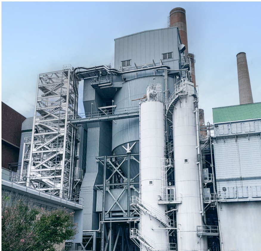
SDA-System am Kessel 1 des TVA-Kraftwerks Shawnee
